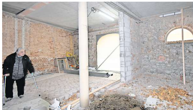
Schlossvereinsvorsitzender Jürgen Ullrich erklärt in der künftigen Haugwitz-Stube, was der Verein nach der Sanierung dort plant.
